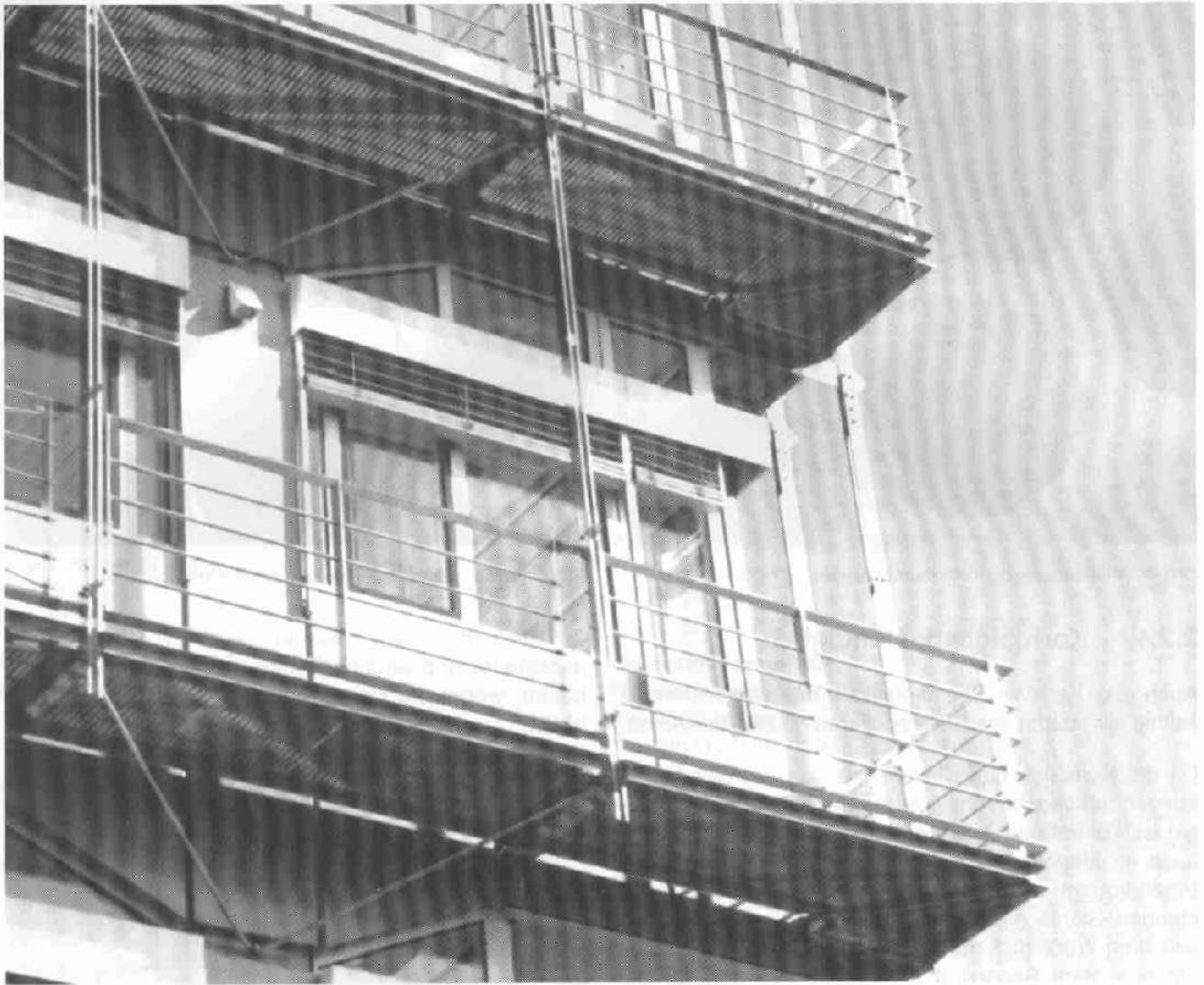
Bild 7: Balkon und Tragwerkkonstruktion aus dekorativ elektropolierem Edelstahl Rostfrei in einem Industriegebiet mit belasteter Atmosphäre
