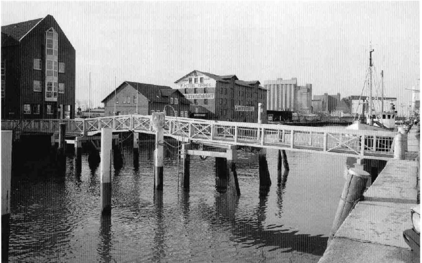
Brückengeländer aus nichtrostendem Stahl, Husum
