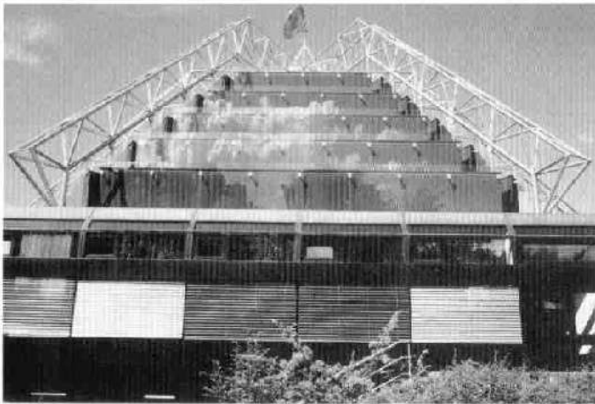
Planetarium Stuttgart mit Tragwerk aus Edelstahl Rostfrei
